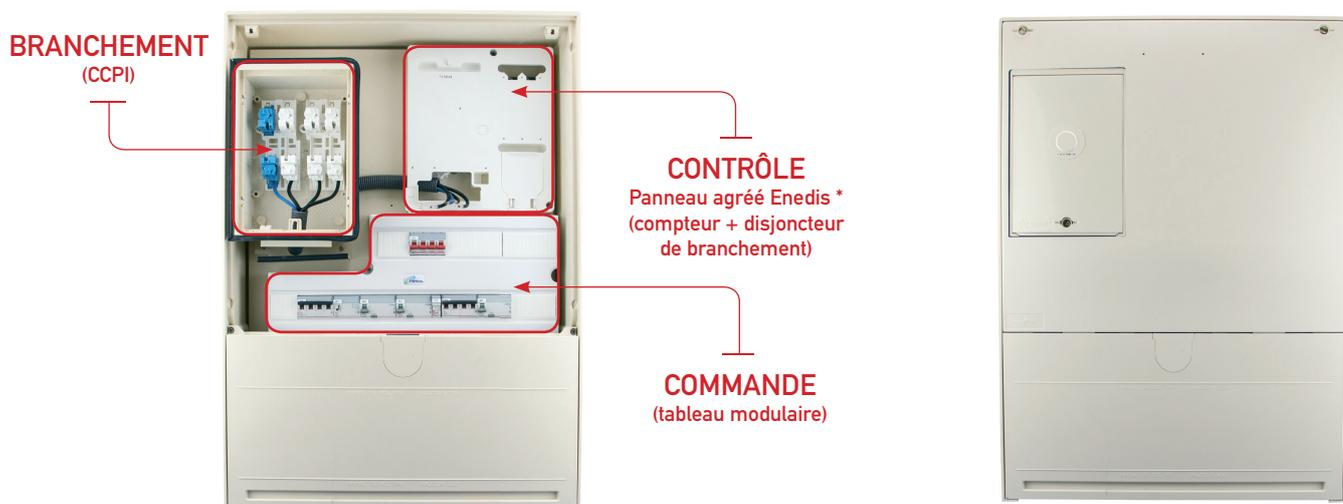
*\*La séparation entre la norme NF C 14-100 du domaine public et la norme NF C 17-200 du domaine privé est assurée par l'intermédiaire d'un panneau agréé Enedis. Une séparation par une porte ou un compartiment différencié n'est pas nécessaire dans ce cas entre les fonctions Contrôle et Commande*
